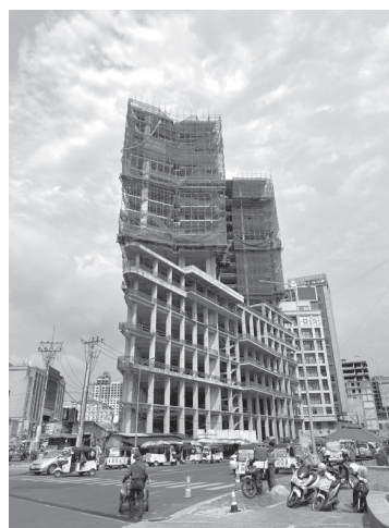
写真4 中国投資で建設中の高層ビル 李撮影 (2023年2月)
